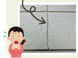
外壁材の継ぎ目や窓サッシまわりのゴムの部分を**シーリング**といいます。このシーリングにひび割れがある場合は、シーリングが劣化をしている証拠になります。シーリングの打ち替えを行いましょ。
