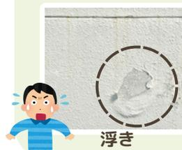
**浮き**とは、経年劣化によって塗膜が外壁から離れ水膨れのように浮いている状態です。塗装が浮いている箇所は、外壁から塗膜が離れているので、簡単に剥がれてしまいます。見た目が悪いだけでなく、塗料の働きができていません。
