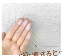
外壁を触った際、チョークのような白い粉がつくことがあります。これを**チョーキング**といい、雨や紫外線などで塗膜が劣化し、色をつける「顔料」が粉状になって露出していることです。塗料が持つ外壁を守る働きができなくなり、このままチョーキングを放置すれば外壁の**ひび割れ**が起きます。そして、雨が外壁から侵入して**雨漏り**の原因に繋がるのです。
