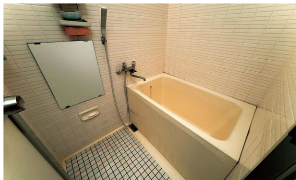
Before 在来工法 壁がタイル貼りになった浴室
